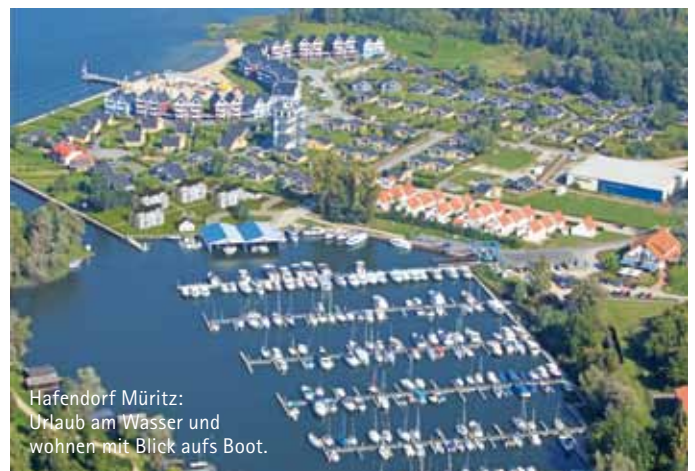
Zwei von vier Apartmenthäusern auf der Landzunge zwischen Müritz und Claassee sind im Rohbau fertig.
